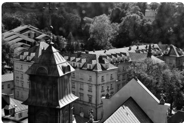
Budynek seminarium — widok z wieży katedralnej
