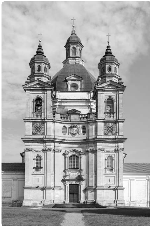
Fasada kościoła w Požajściu
