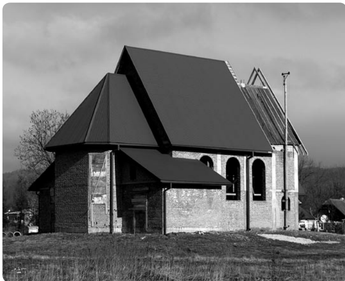
Stan prac przy budowie kaplicy w Zasławiu; zdjęcia wykonane 17 lutego br.
