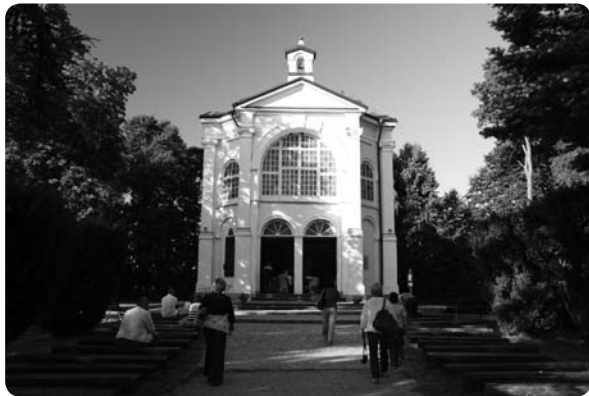
Kaplica w Studzienicznej
