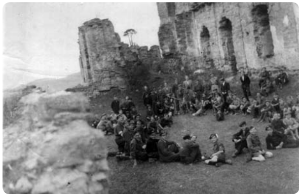
Zbiórka w ruinach klasztoru, 1946
